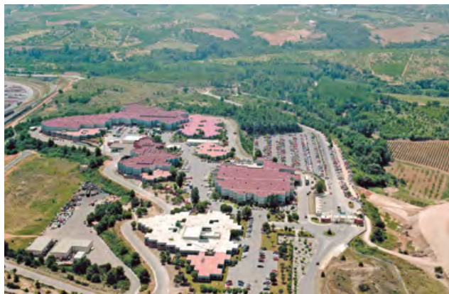
CENTRO TECNICO IN MARTORELL
