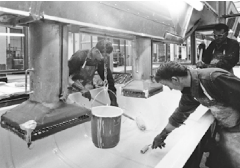
Hochdachfertigung für den Transporter, 1968; die Dächer wurden aus dreilagigen mit Kunstharz laminierten Glasfasermatten gefertigt.
