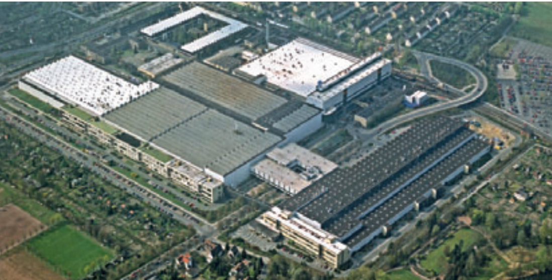
Luftaufnahme mit der Halle 7 im Vordergrund, 1991
