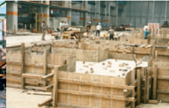
Maschinenfundamente, 1986
