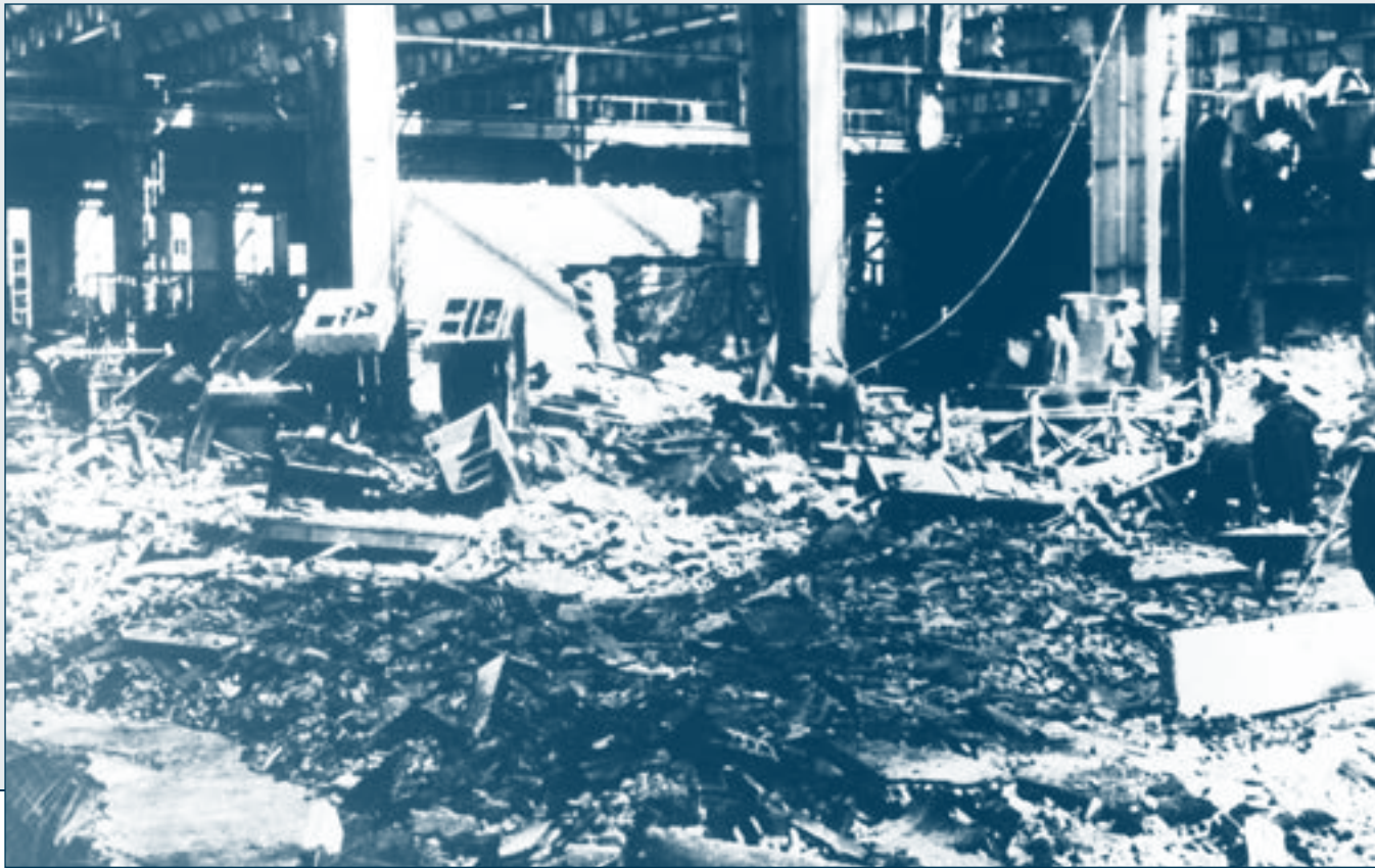
Zerstörungen im Presswerk
