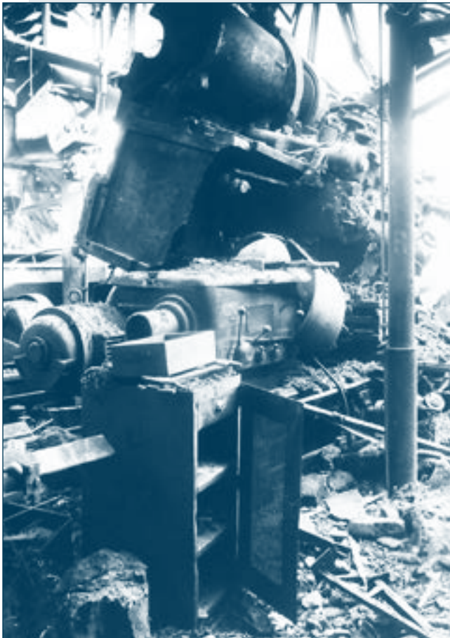
Bombenschäden im Presswerk
