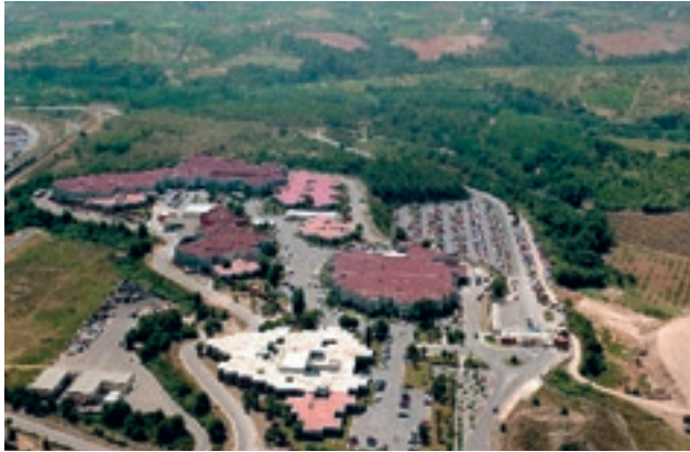
DAS „CENTRO TECNICO“ IN MARTORELL
