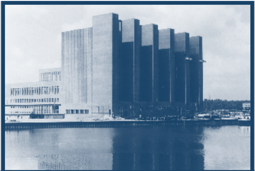
Südostblick auf das Kraftwerk, August 1939
