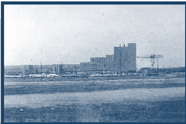
Südansicht des Kraftwerks, April 1945
