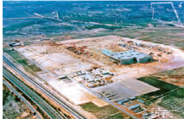
WERK PALMELA IM ROHBAU
