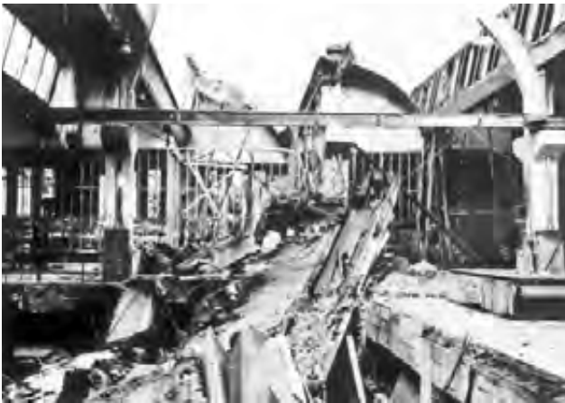
BOMBENSCHÄDEN IM HAUPTWERK
