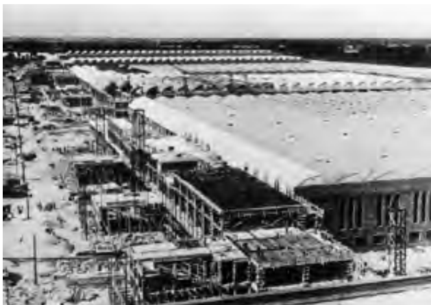
HAUPTWERK IM ROHBAU
