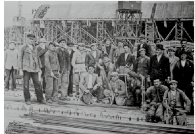
ITALIENISCHE BAUARBEITER IM HAUPTWERK
