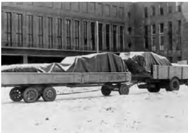
ABTRANSPORT VON FLUGBOMBEN AUS DEM HAUPTWERK
