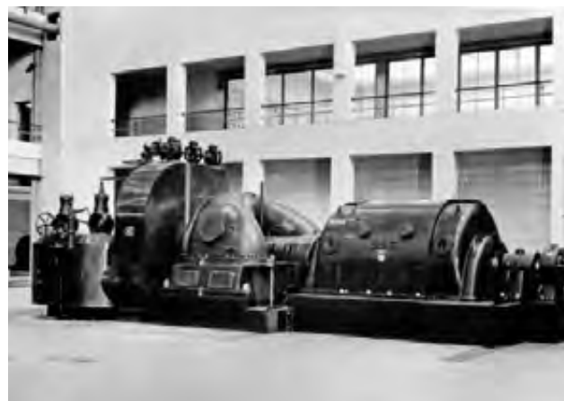
TURBINENSATZ IM KRAFTWERK
