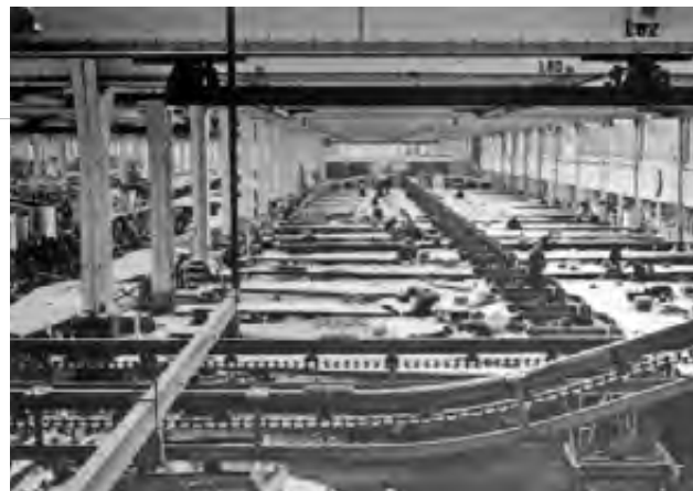
TRAGFLÄCHENREPARATUR IM HAUPTWERK
