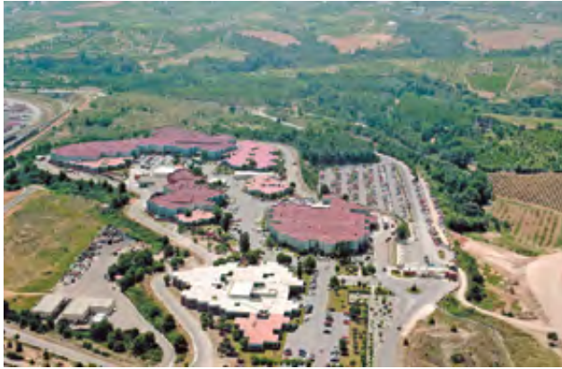
CENTRO TECNICO IN MARTORELL
