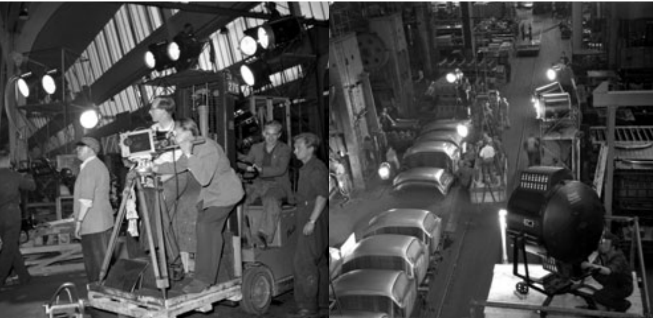
Filmteam bei den Dreharbeiten von „Aus eigener Kraft“, 1953; Kamerafahrt in der Pressenstraße, 1953
