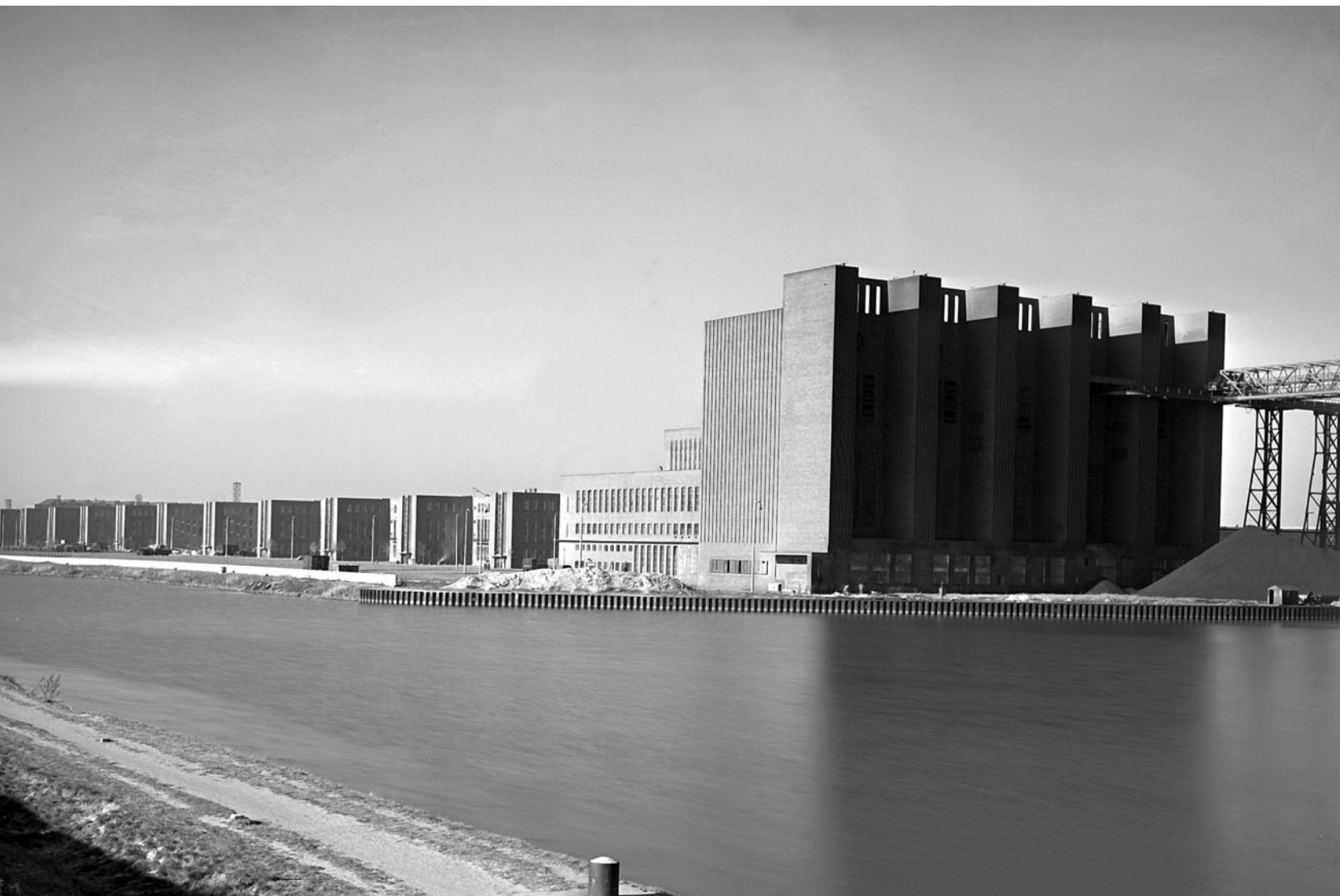
Werk von Südosten
