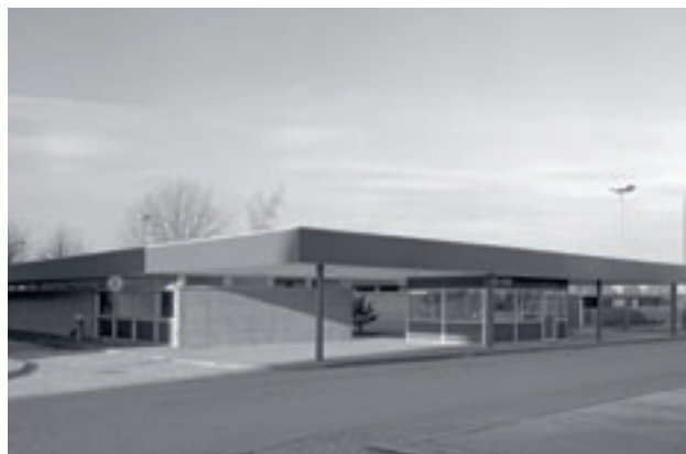
TOR AN DER GIFHORNER STRASSE IN BRAUNSCHWEIG 1984
