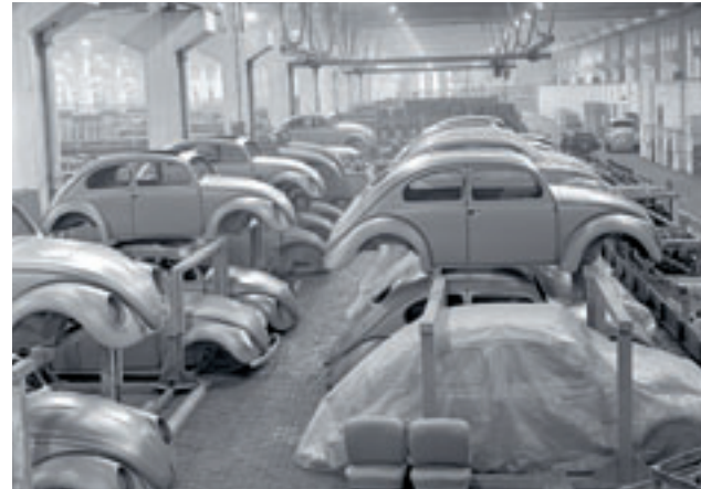
KÄFER IM ROHBAU
