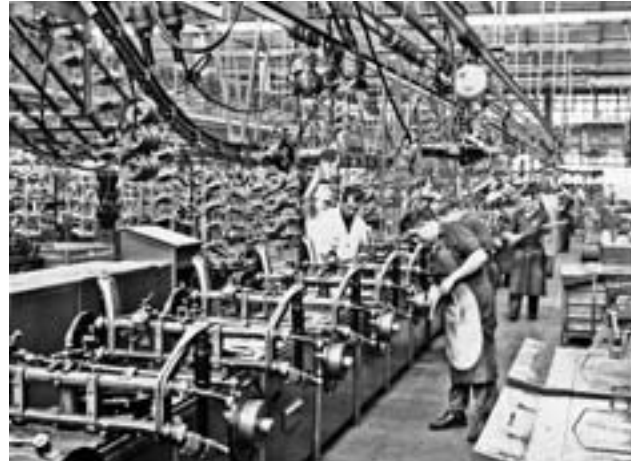
Bremstrommelmontage an der Vorderachse, 1967
