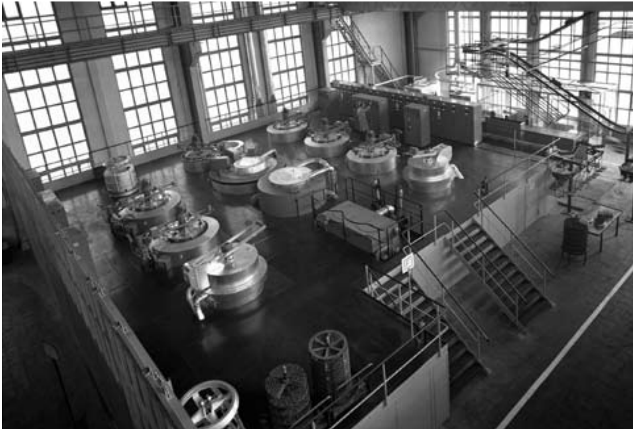
Anlage zur Gasaufkohlung in der neuen Härtereie in Halle 4, 1963
