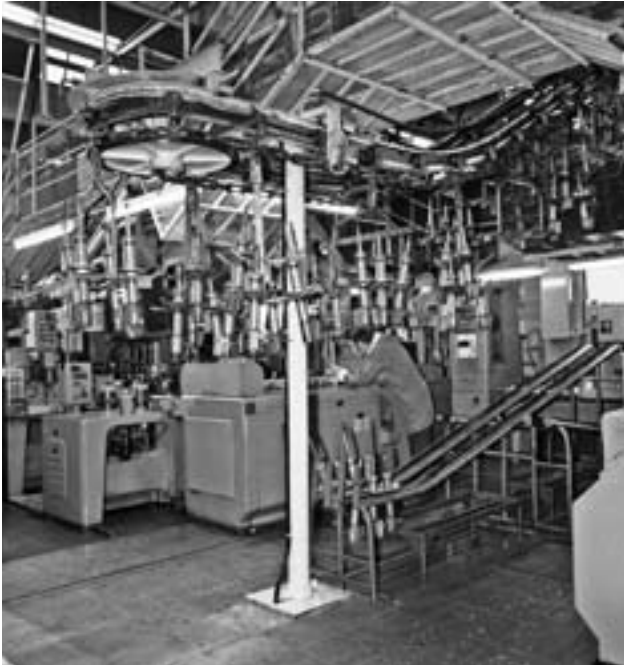
Fertigungsstraße für Federbeine – Gesamtfertigung 1977 mehr als 1,6 Millionen Federbeine für alle Volkswagen Typen und für den Audi 80, 1977
