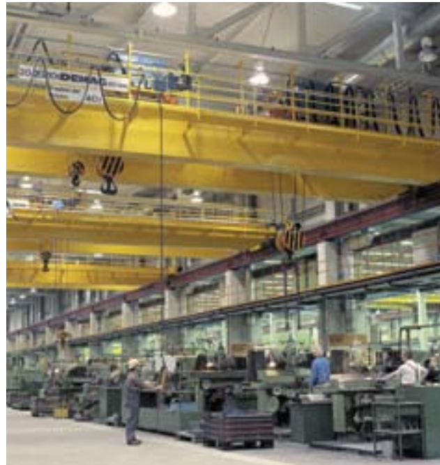
Der Maschinen- und Werkzeugbau in der neuen Halle 7, 1987
