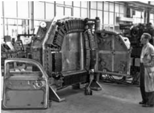
Der Schweißmaschinenbau, hier einer Türensweißanlage, bildete einen wichtigen Fertigungsbereich, 1954
