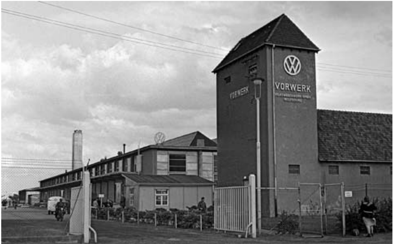
Das Trafohäuschen an der Gifhorner Straße mit dem Schriftzug Vorwerk und dem Volkswagen Zeichen, 1950
