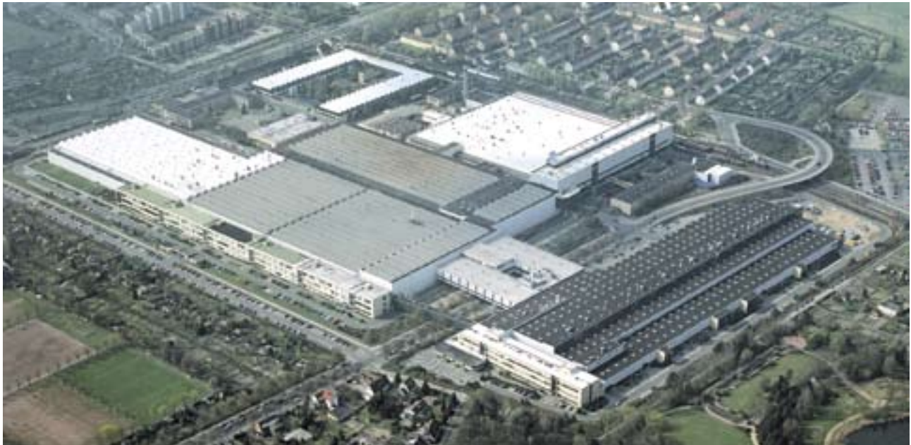
Das Werk Braunschweig aus südöstlicher Richtung, 1991
